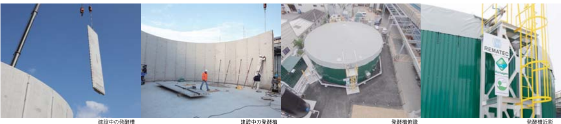
建設中の発酵槽
