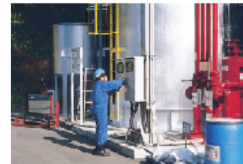
泡消火設備の点検
