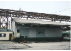
藤原供給プラント
