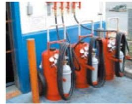
2003年11月14日に火災が発生しました。大事には至りませんでした。その教訓を活かし工場の屋外2箇所に大型消火器および消火配管を設置しました。遠隔操作で全タンクの消火が可能になり、有事に対応した設備化ができました。
