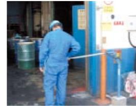
工場では、有機溶剤系の廃棄物を取り扱っております。人体に帯電する静電気火花による引火爆発対策として、工場の入口2箇所に除電棒を設置しました。
