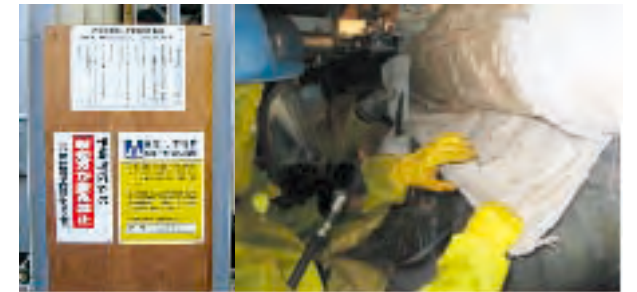
アスベスト含有資材撤去作業
