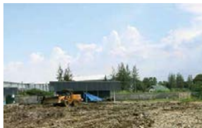
着々と整備が進む事業計画用の敷地
