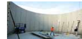
メタン発酵槽組立の様子
