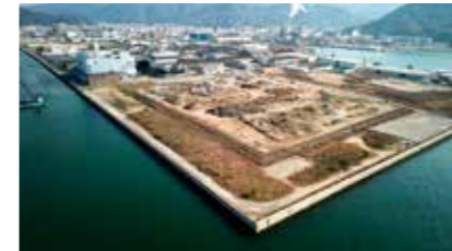
呉市災害廃棄物二次仮置全景
