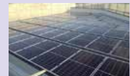
摂津事務所屋上
