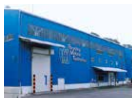
九州工場RFプラント建設（1988年）
