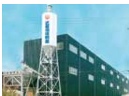
大阪工場RFプラント建設（1983年）
