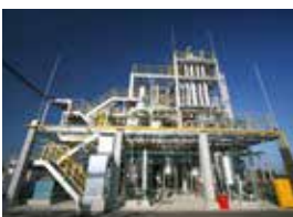
亜臨界水処理プラント建設(2006年)
