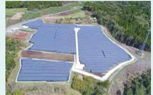
鹿児島第二発電所
